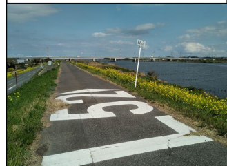
撮影ポイント CP2 「海から52km」標識
