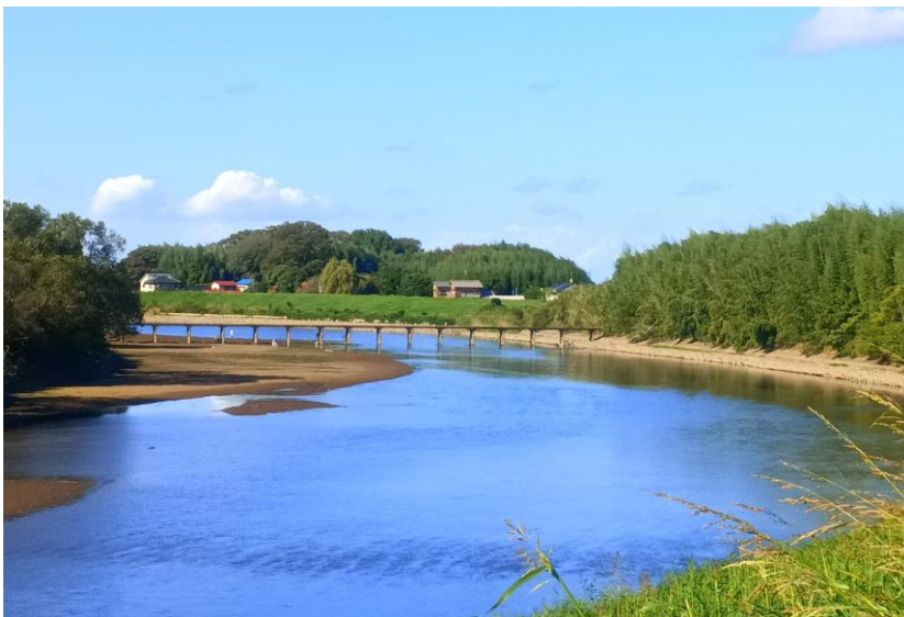
小目沼橋の『遠景』
